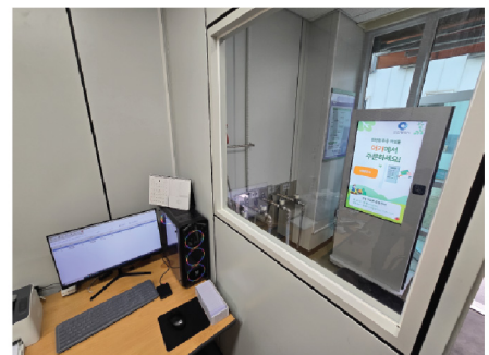
자동 분주 키오스크 설치
