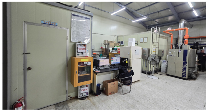
작업 전 작업현장+저온냉장고+보일러 이설 전
